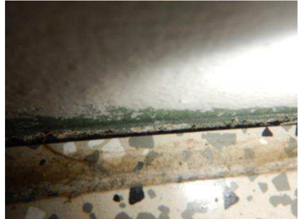
Kuva 260. Liitoksessa ei havaittu puutteita tai suuria rakoja.
