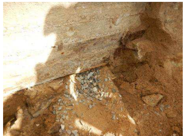
Kuva 293. Putkikanaalin alla maataytön hiekka on vaihdettu karkeaan soraan.
