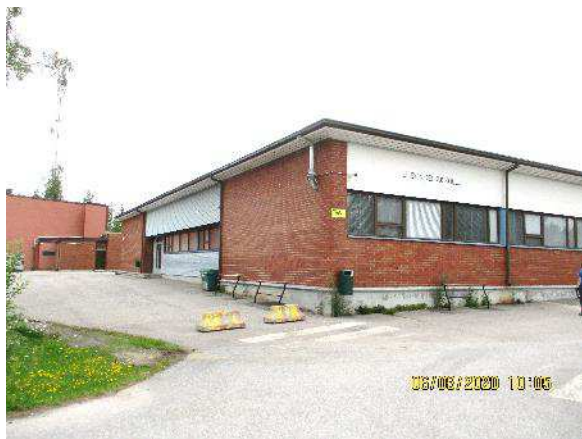
Kuva 88. Yleiskuva 1970-luvun laajennusosasta.
