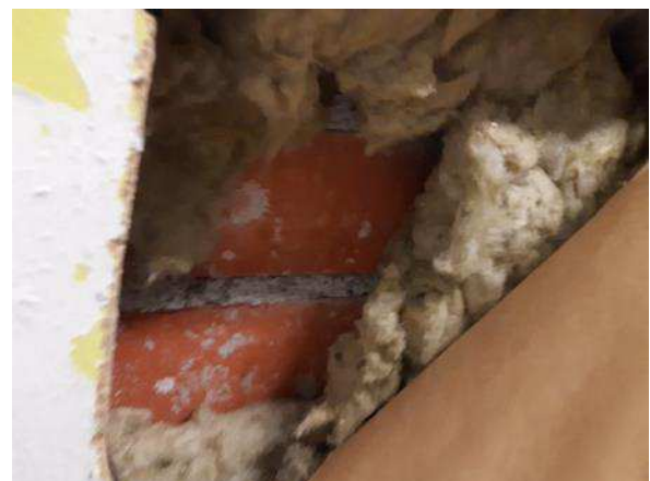
Kuva 163. Mineraalivillaeristeen takana on tiilimuuraus.
