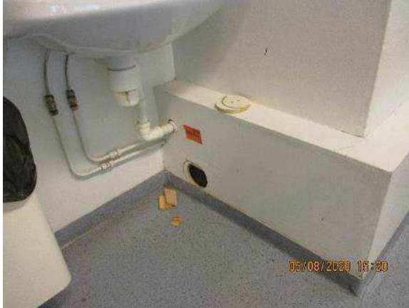
Kuva 255. Rakenneavaus tehtiin käsienpesualtaan alle putkikoteloon.
