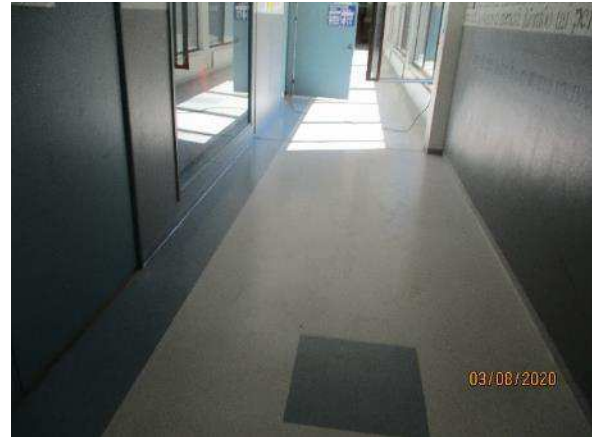
Kuva 222. Välipohjien lattiapäällysteenä oli aulatiloin lukuun ottamatta muovimatto.
