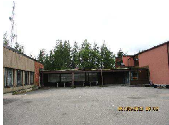
Kuva 83. Ruokala- ja liikuntasalin yhdistää kaksi kerroksiseen luokkasiipeen matalampi käytävä- ja luokkiosa.
