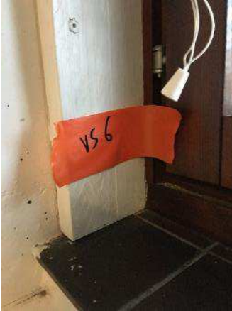
Kuva 269. Rakenneavaus tehtiin luokkien väliseen levyrakenteeseen ikkunaliittymässä
