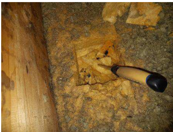
Kuva 373. Rakenneavaus YP3 tehtiin havaitulle vuotoalueelle.
