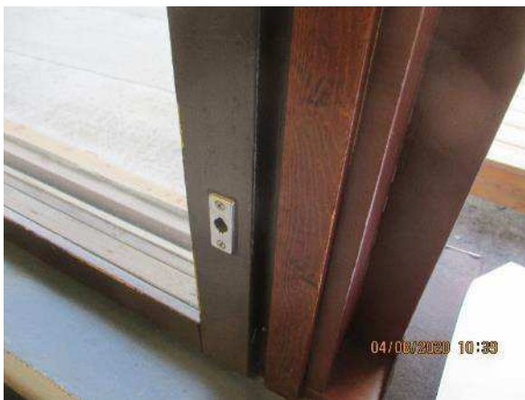
Kuva 178. Rakenneavaus US 31 ikkunaliitos.
