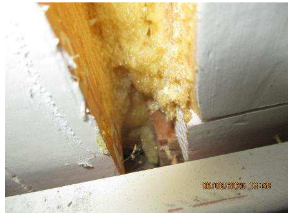
Kuva 173. Kuva avauksesta US 29, ikkunatiivisteenä on uretaanivaahdotus.
