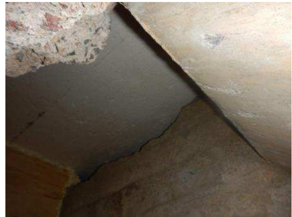
Kuva 228. Kuva luukusta kiinteistöhoitajan huoneen kohdalla.
