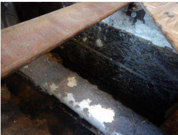
Kuva 292. Putkikanaalin seinämät oli eristetty bitumisivelyllä.
