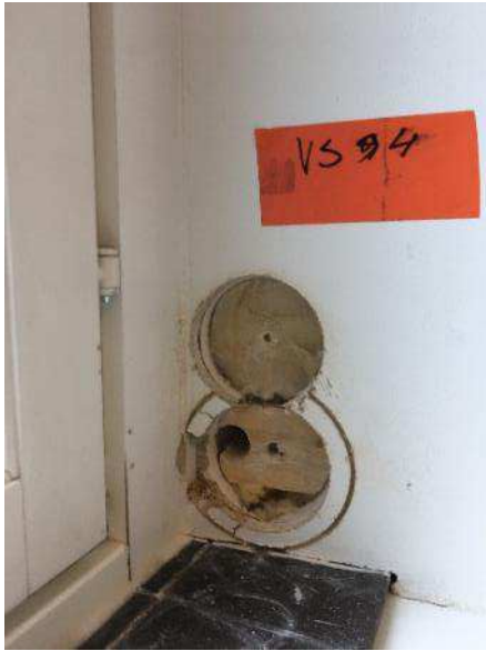
Kuva 261. Rakenneavaus tehtiin väliseinärakenteeseen ikkunan viereen.
