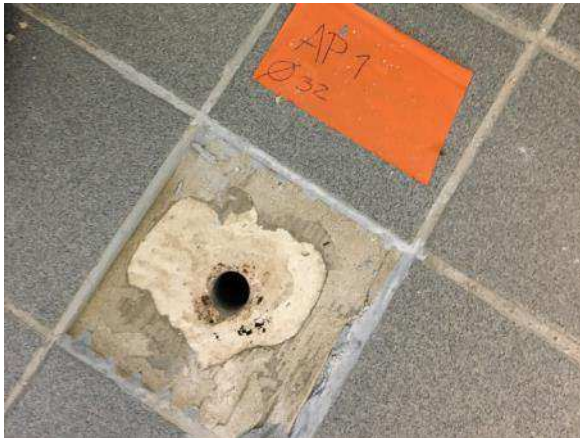
Kuva 16. Rakenneavaus 34 OT 3 luokan ikkunaseinän vieressä nurkassa.
