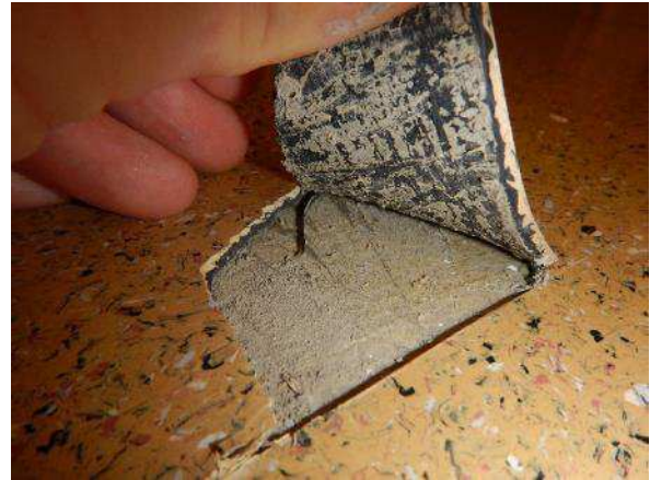
Kuva 52. VM1: 5 Fysiikka/kemia-luoka lattiamatossa tai sen kiinnitysliimassa ei havaittu poikkeavuuksia.
