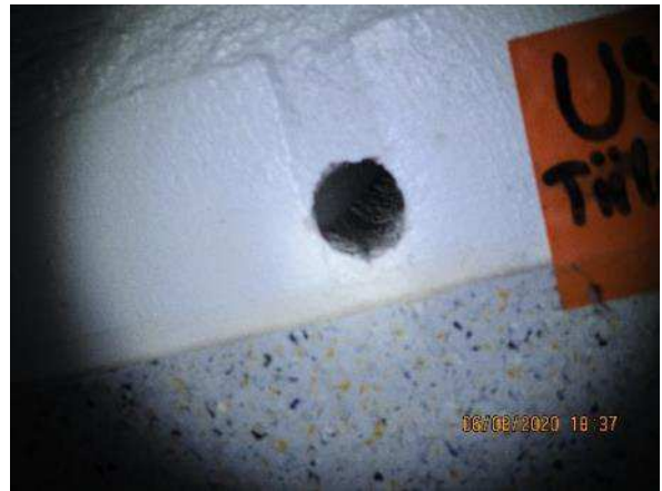
Kuva 156. US20: Rakenneavaus suoritettiin poraamalla.
