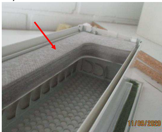
Kuva 494. Pajarakennus, tuloilmapäätelaitteiden vaimenusmateriaali on polyesteripohjaista (ei mineraalivillaa)
