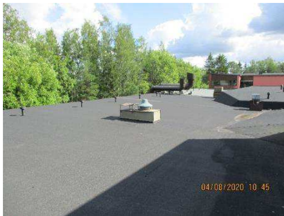
Kuva 308. Yleiskuva vesikatteesta aula 1006 yläpuolelta.
