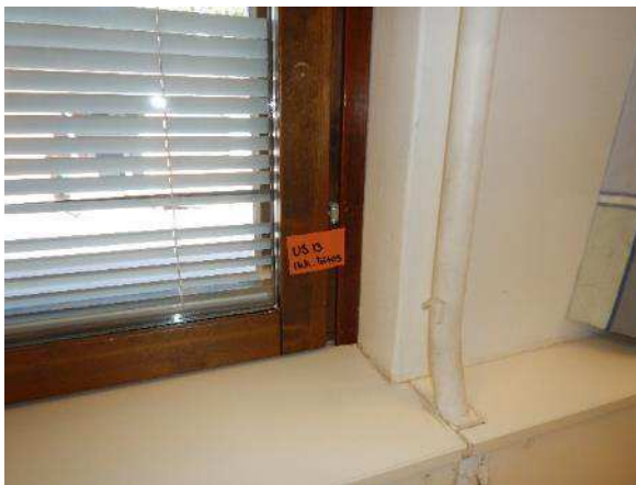
Kuva 136. Rakennusavaus tehtiin ikkunan ja pilarin liittymään.
