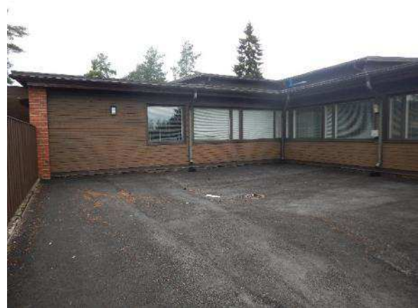
Kuva 396. Pajan sisäpinnan puolella sadevedet on ohjattu sisäpihan keskellä olevaan sadevesikaivoon kaatojen avulla.
