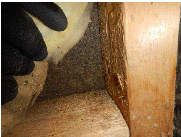
Kuva 169. Mineralivillan takana on puukuitulevy.
