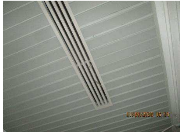
Kuva 404. Laajennusosan käytävien ja luokkatilojen alaslaskut on tehty peltipaneelikatolla.
