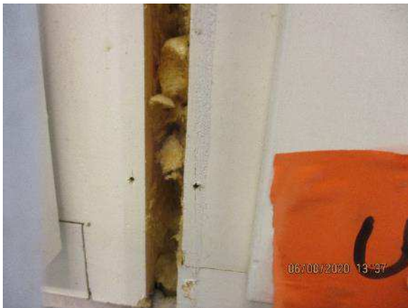
Kuva 172. Rakenneavaus US27. Ikkunatiivisteenä on uretaanivaahdotus
