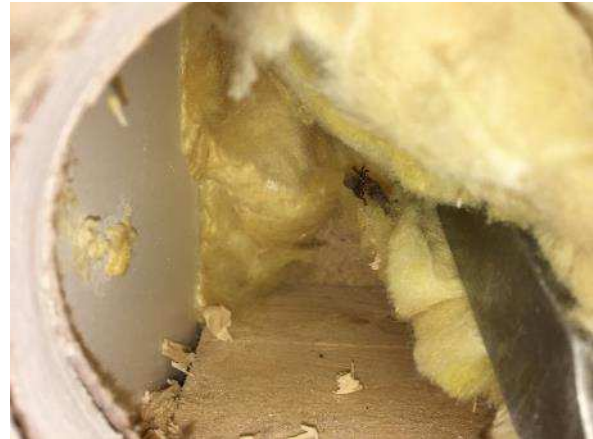
Kuva 262. Väliseinän ja ikkunan välinen liitos oli eristetty mineraalivilla väliseinän leveydeltä
