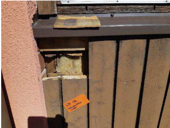
Kuva 130. Rakenneavaus US 12 tehtiin ikkunan alapuolelle.
