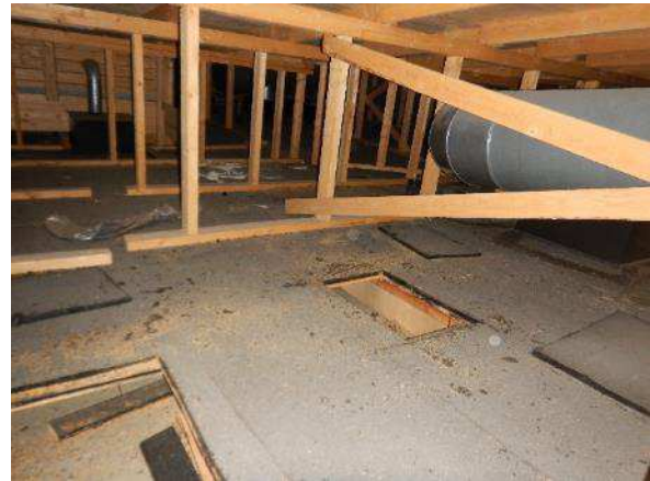
Kuva 361. Kuva tuuletusaukoista rakennuksen keskellä.
