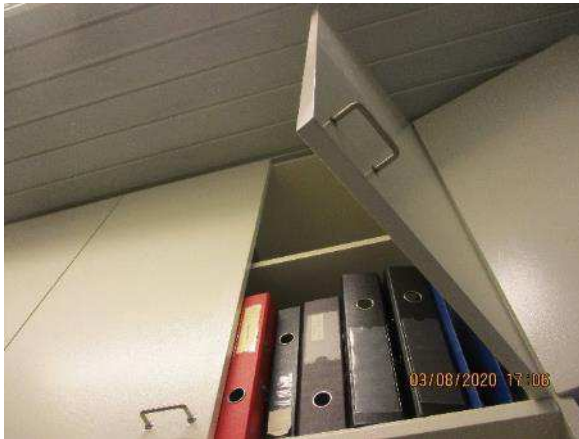
Kuva 283. Käytävän ja toimistuhuoneiden välissä on kiinteät kaapistot.
