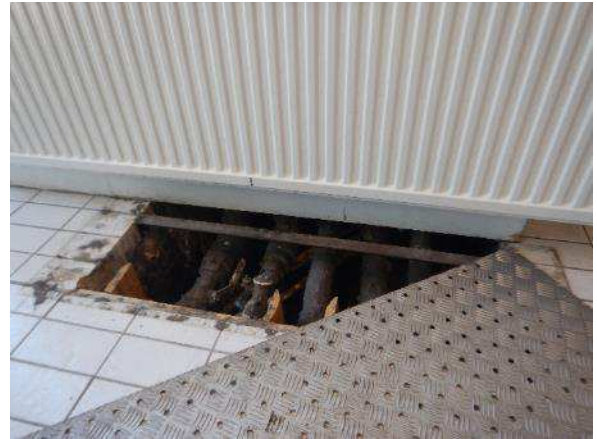
Kuva 291. Kuva laajennusosan ulkoseinällä sijaitsevan putkikanaalin luukusta (tuulikaappi 1066).
