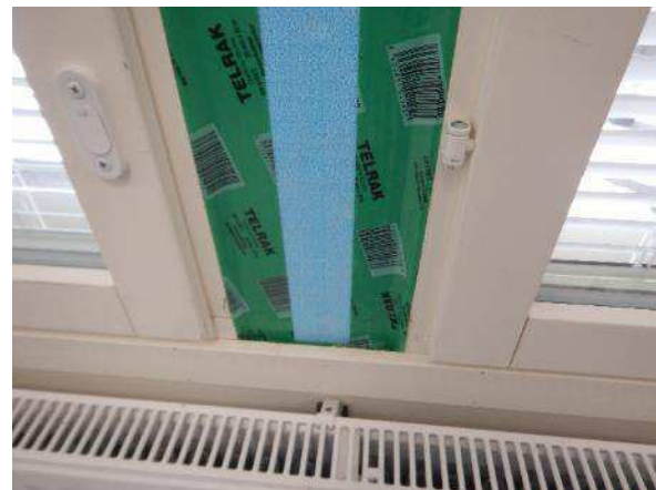
Kuva 140. Yleiskuva rakenneavauksesta US14. Peitelistan takana ikkunaliittymät on tiivistetty huolellisesti höyrynsulkuteipillä
