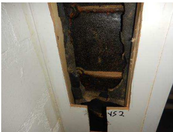
Kuva 257. Rakenneavaus VS2 selvitettiin pystyviemäriputken tarkastusluukusta.
