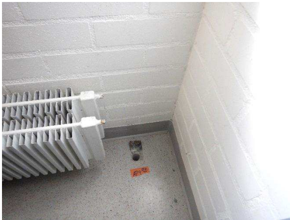
Kuva 35. Rakenneavaus AP9 tehtiin kielten varastoon.
