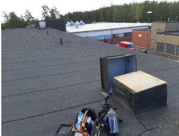
Kuva 322. Vesikatolla ei ole yläpohjatilaan johtavia tarkastusluukkuja.
