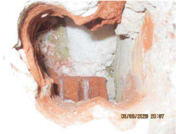
Kuva 113. Rakenteeseen on lisätty jälkikäteen ureaformaldehydivaahtoeristettä ruiskuttamalla.
