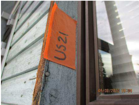
Kuva 157. US21:stä tarkastettiin ikkunan liitostapa ulkoseinään.
