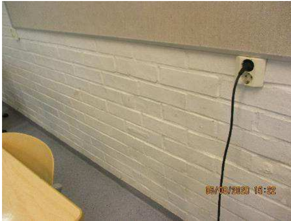
Kuva 251. Kantavat väliseinät olivat 1. ja 2. kerroksessa pääosin tiilirakenteisia.
