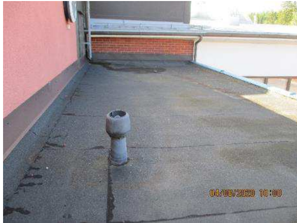
Kuva 334. Yleiskuva laajennusosan ja alkuperäisen osan sisäänkäynnin yläpuolisesta vesikatto-osuudesta.
