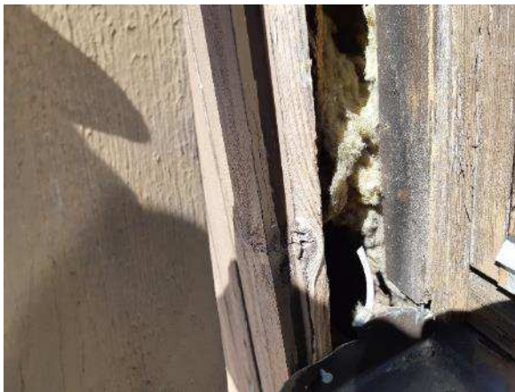
Kuva 132. Rakenneavaus US 11 tehtiin ikkunoiden väliseen panelointiin.
