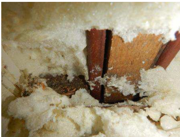
Kuva 141. Ikkunaliitosten eristeenä oli uretaanivahto. Rakenteessa on havaittavissa alkuperäisten ikkunoiden karmirakenteet.
