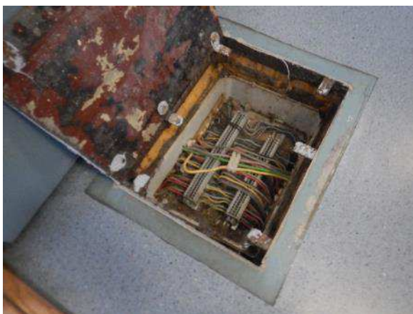
Kuva 15. 1970-luvun laajennuksen lattiassa on paikoin sähköpistokeluukkuja, joista osa on poistettu käytöstä (kuvassa).
