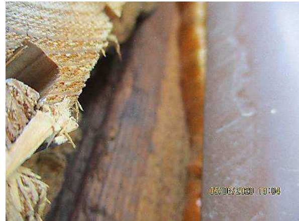
Kuva 158. US21: Ikkunaliitos on tiivistetty uretaanivaahdolla.
