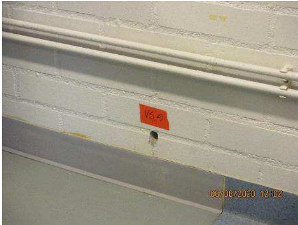
Kuva 275. Rakenneavaus tehtiin 4 Fysiikka/kemia ja 1048 siivousvaraston väliseinään, joka on vanha ulkoseinä.
