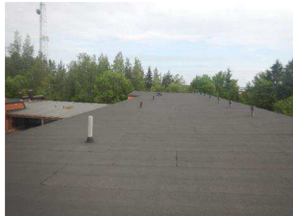
Kuva 319. Yleiskuva toisen kerroksen vesikatosta.
