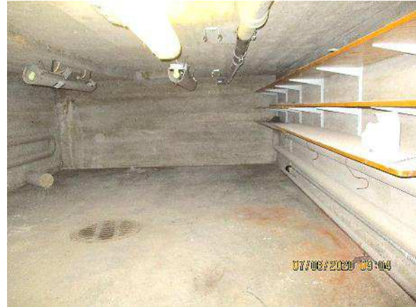
Kuva 40. Rakenneavauksen alapuolella havaittiin putkikanaalin pää.
