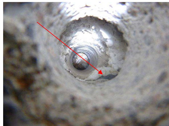
Kuva 22. Eristekerroksen päällä havaittiin bitumisively.
