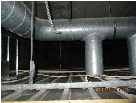
Kuva 405. Paneelien on pääosin poistettu mineraalivillaiset eristelevyt.
