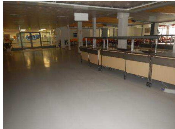
Kuva 224. Ruokalan välipohjan pinnoitteena on epoksimaali.
