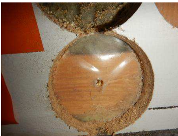
Kuva 121. Rakenneavaus US8 yleiskuva kauempaa avauskohdasta, mihin tehty.
