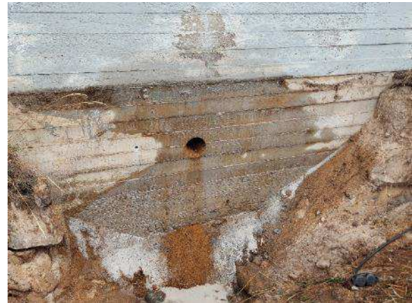
Kuva 102. Rakenneavaus porattiin timanttioralla maanpinnan alapuoliselle alueelle.
