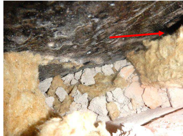
Kuva 118. RakenneavausUS6: Mineraalivillaeristeen ja ulkokuoren välissä oli ilmarako.
