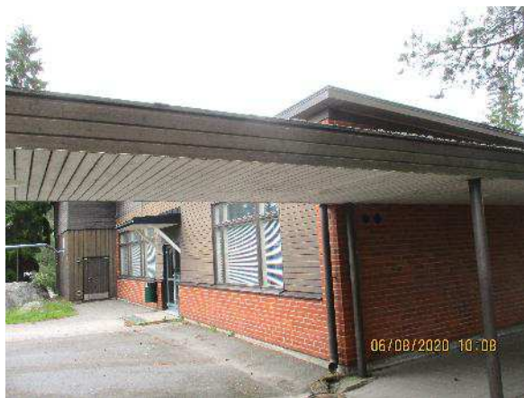
Kuva 92. Pajarakennuksen sadevedet ohjautuvat loiskekivetyksen kautta sadevesikaivoihin, joissa havaittiin paikoin roskia.
