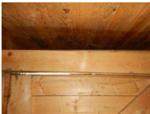
Kuva 356. Yläpohjan tuuletus on toteutettu räystäiden alta.
