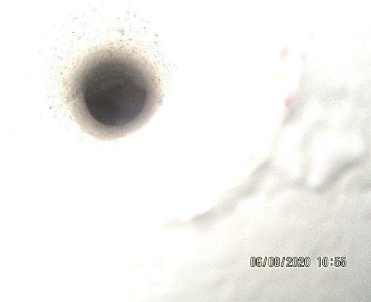
Kuva 152. Rakenneavaus US 18:Rakenteen lämmöneristeenä on käytetty mineraalivillaeristettä.
