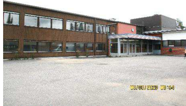
Kuva 85. Yleiskuva luokkasiivestä, joka koostuu kellarikerroksesta sekä kahdesta maan päällisestä kerroksesta.
