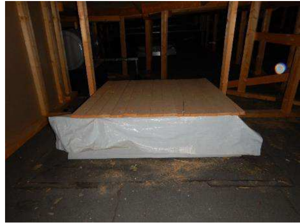
Kuva 359. Vanhat kattoikkunat on laudoitettu umpeen.
