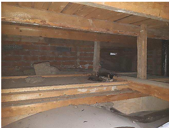
Kuva 367. Rakenneavaus YP1 tehtiin aulaan 1006 ja kuraattori 1008 alueelle.
