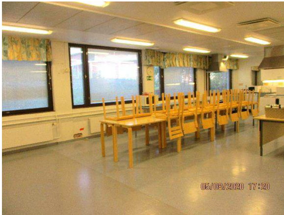
Kuva 7. Yleiskuva kellarikerroksen kotitalousluokasta. Lattiapäällysteenä on muovimatto.
