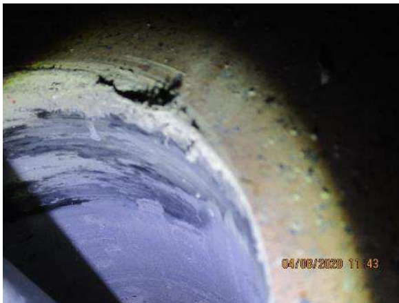
Kuva 237. Rakenneavaus VP4, rakenne on massiivibetonirakenteinen.
