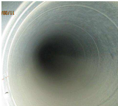
Kuva 463. TK03 palvelualue, poistoilmakanava luokassa 9. Kanavassa normaalia lievää pölykertymää.
