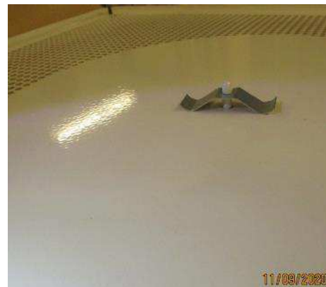
Kuva 489. TK05 palvelualue, luokka 30, TKB-mallisen tuloilmapäätelaitteen levy puhdas
