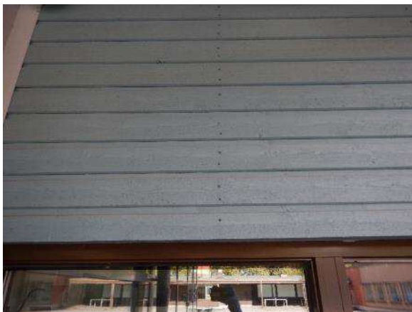
Kuva 126. Ulkoseinän verhouksena on panelointi.
