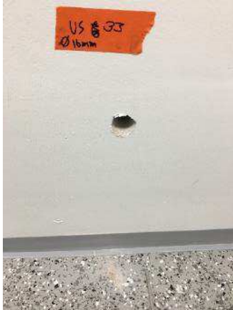
Kuva 71. Rakenneavaus US33 pyrittiin selvittämään vanhojen porrarakenteiden alapuolen rakennetta. Havaintojen perusteella porrarakenne on massiivibetonirakenteinen,
