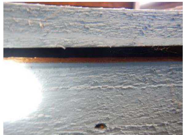
Kuva 127. Tuulensuojalevyn ja julkisivupaneelin välissä on tuuletusväli.
