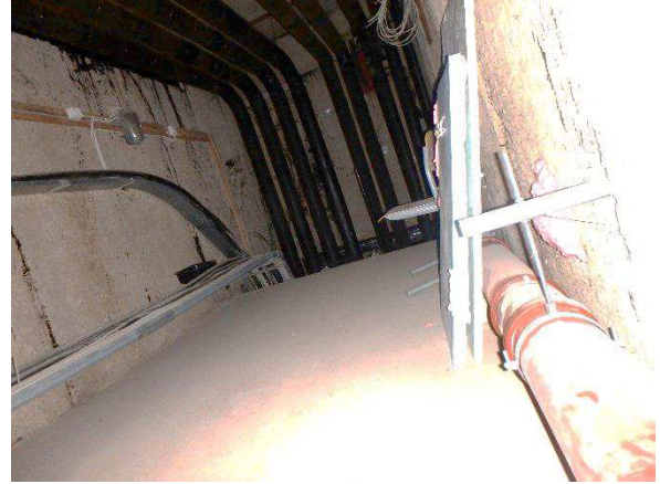
Kuva 289. Yleiskuva alkuperäisen osan 1. kerroksen ja laajennusosan käytävien alla olevasta putkikanaalista (Putkikanaali 2).
