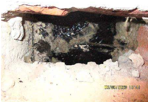
Kuva 115. Rakenneavaus US6 tehtiin kotitalousluokkaan 31.
