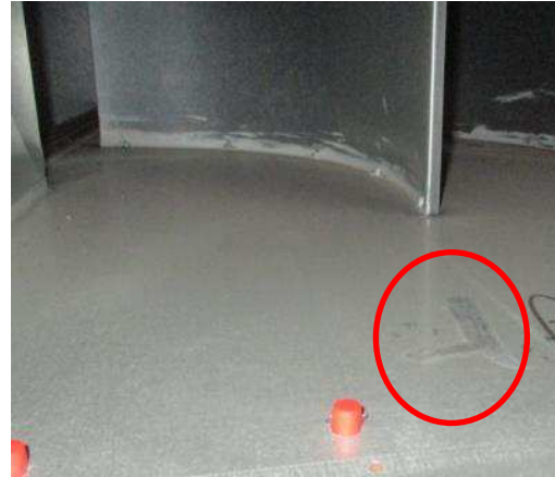
Kuva 460. TK03 palvelualue, tuloilmakanava iv-konehuoneessa. Kanavan pohjalla lievää pölykertymää, pyyhkäisyjälki kuvassa
