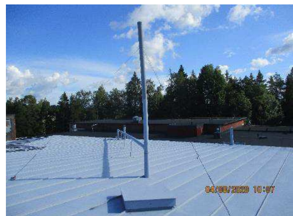
Kuva 333. Laajennusosan vesikatteella on viemärin tuuletusputkia, joita on johdettu kauemmas IV-koneen tuloilmanottoaukosta.
