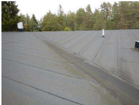
Kuva 348. Yleiskuva pajarakennuksen korotusosan vesikatteesta.
