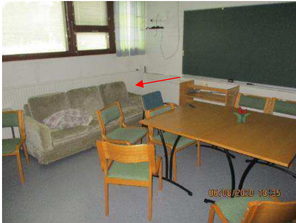
Kuva 164. Rakenneavaus US 38 tehtiin poraamalla kuvaan merkitylle alueelle.
