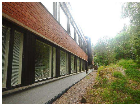
Kuva 394. Yleiskuva rakennuksen takaa. Rakennuksen vieressä on kallio, joka ulottuu maanpinnan yläpuolelle.
