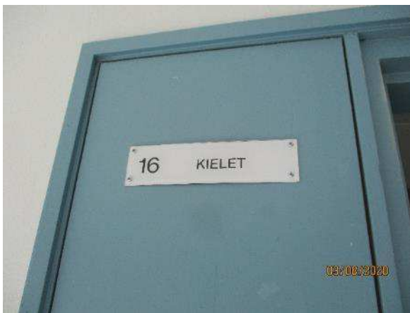
Kuva 273. Rakenneavaus tarkistettiin 16 Kielet kohdalta.
