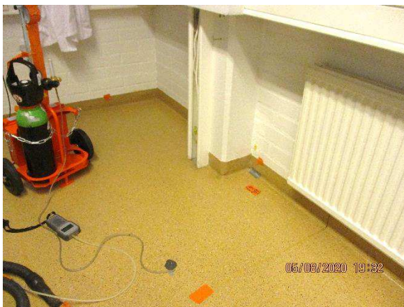
Kuva 29. Rakenneavaus AP7, tehtiin luokkaan 5. Fysiikka/Kemia.
