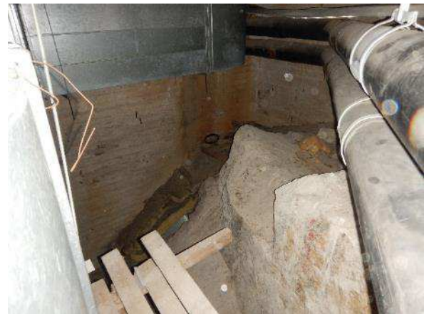
Kuva 49. Yleiskuva betonilaatan alapuolelta.
