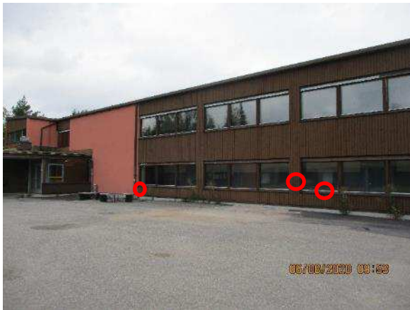
Kuva 128. Yleiskuva, johon merkittynä rakenneavauskohdat
