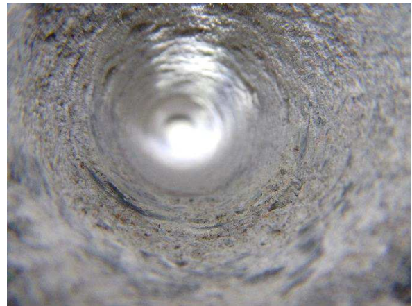
Kuva 36. Poraus osui betonilaatan reunavahvistuksen kohdalle.
