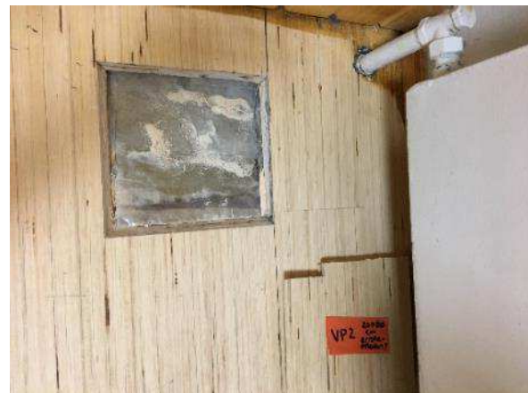
Kuva 45. Rakenneavaus AP16 tehtiin ulkoseinän viereen.
