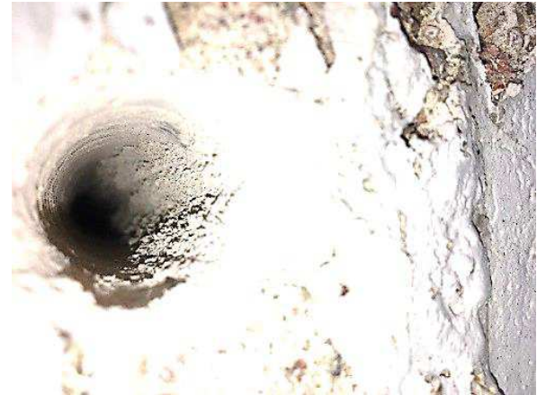
Kuva 190. Sokkelirakenne on massiivibetonirakenteinen
