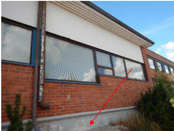
Kuva 101. Rakenneavaus tehtiin sokkeliin luokan 4 Fysiikka/kemia ulkopuolella..
