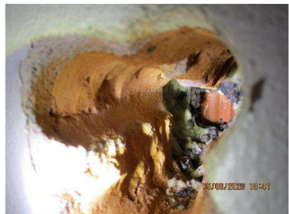
Kuva 177. Rakenneavauksesta US30 otettiin mikrobimateriaalinäytteet laboratorioanalyysiä varten. Näytteissä ei havaittu viitettä vauriosta.
