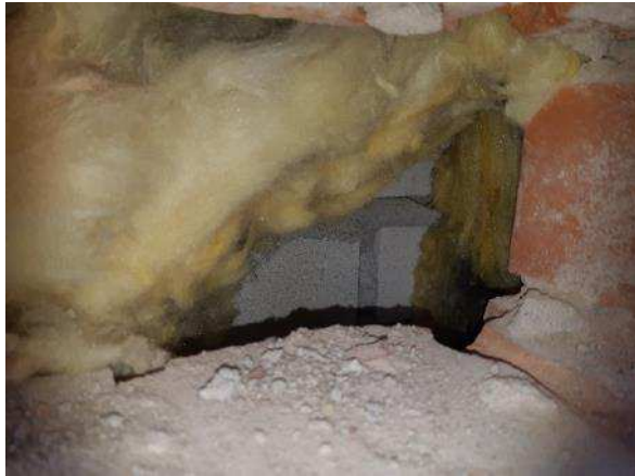
Kuva 153. US19: Eristeen takana on havaittavissa sisäpuolen tiilimuuraus.
