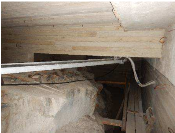
Kuva 48. Kantavan betonilaatan alapuolella on ilma-tila, joka rajautuu louhittuun kalliopintaan. Kallion pinnalla on havaittavissa poistettuja muottilautoja, mutta ei lastusementtilevyeristettä.
