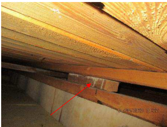
Kuva 326. Yläpohjatilassa ei havaittu viitteitä puutteellisen tuuletuksen aiheuttamista puurakenteiden vaurioista. Tukirakenteissa on käytetty muottilaudoituksia, joiden pinnalla on havaittavissa betoni- ja sementtijäämiä.
