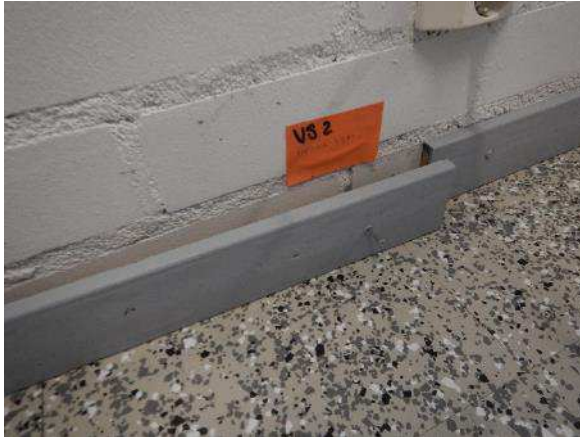
Kuva 259. Rakenneavaus VS 2 tehtiin kantavan väliseinän ja lattian liitokseen.
