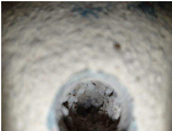
Kuva 34. Rakenneavaus AP8, rakenteessa on kaksoislaattarakenne, jonka lämmöneristeenä on EPS-eriste.
