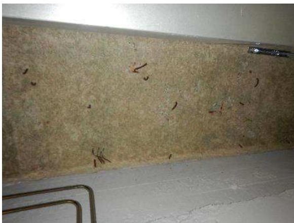
Kuva 225. Kellarikerroksen aula- ja luokkatilojen välipohjan alapinnassa oli puukuitusementtilevyt.
