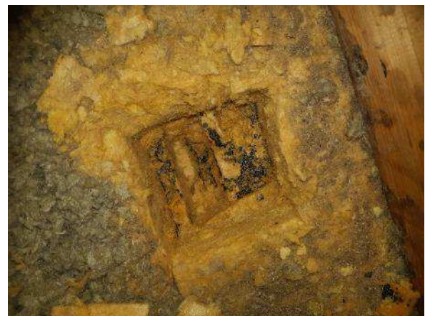
Kuva 374. Rakenne yläpohjan rakenneavauksessa YP3 vastaa rakenneavauksesta YP2 havaittua rakennetta.
