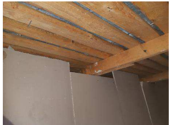
Kuva 370. Aluslaudoituksessa ei havaittu viitteitä vaurioitumisesta. Palokatko on epätiivis.
