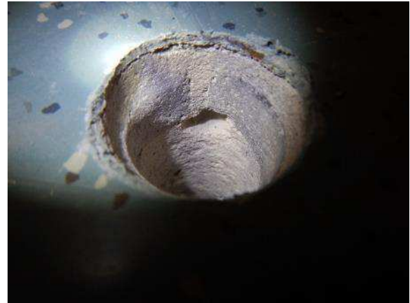
Kuva 42. Rakenneavauksesta on havaittavissa alkuperäinen kivilaattapinta.
