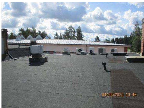
Kuva 314. 1. Yleiskuva ruokalan vesikatolta.
