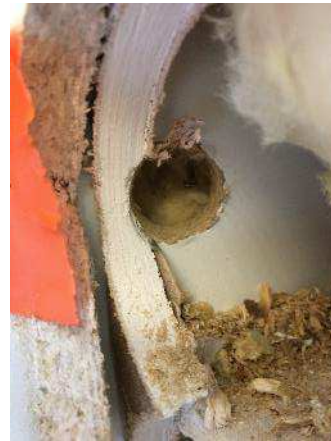
Kuva 149. Väliseinän sisällä on ulkoseinärakenteena lastulevy, jonka takana on mineraalivilla.
