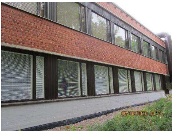
Kuva 107. Rakenneavaus tehtiin 32 Kotitalousluokan ikkunanseinälle avaamalla pellitys ulkopuolelta.
