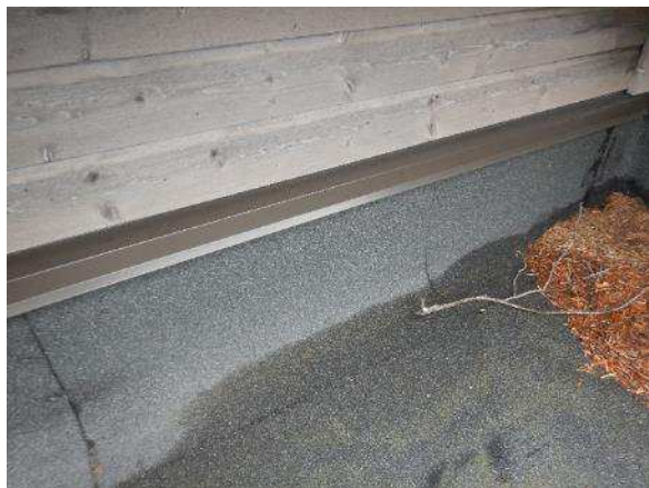
Kuva 344. Pajarakennuksen vesikatteen ylösnostostoissa ei havaittu halkeamia tai puutteita tiivistyksissä.
