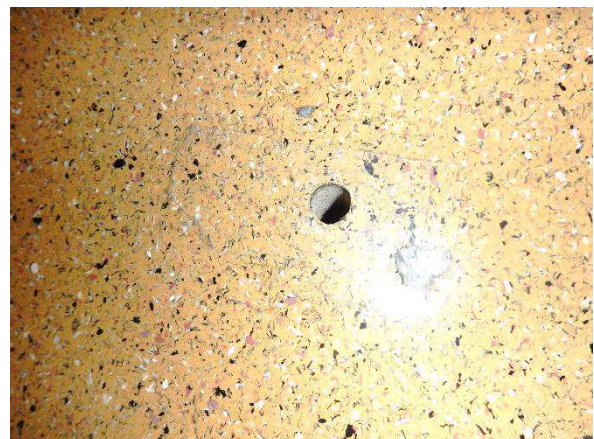
Kuva 30. Rakenneavaus AP7 tehtiin poraamalla.
