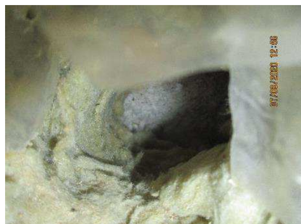
Kuva 232. Kuva rakenneavauksesta VP2. Liikuntasaliin välipohjarakenteena olevassa lattiarakenteessa ei havaittu bitumisivelyä.
