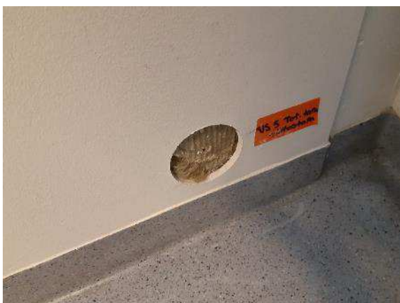
Kuva 263. Rakenneavaus VS 5 tehtiin kevyeen väliseinään.
