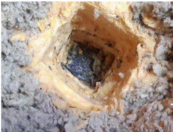
Kuva 369. Rakenneavaus YP2. Rakenne koostuu useasta bitumisively- ja eristekerroksesta. Bitumisivelyiden välissä oleva mineraalivillaeriste on kahden tiiviin vedeneristekerroksen välissä.
