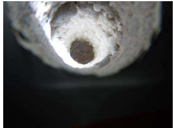
Kuva 239. Rakenneavauksen pohjalla näkyi alapuolen tiilimuuraus
