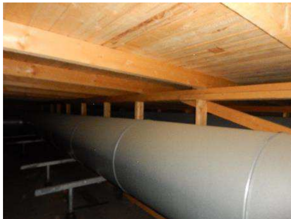
Kuva 354. Pajarakennuksen korotusosan sisällä on ilmanvaihtohormoja. Yläpohjatilassa ei havaittu viitteitä puutteellisen tuuletuksen aiheuttamista puurakenteiden vaurioista eikä vesivuotojälkiä.
