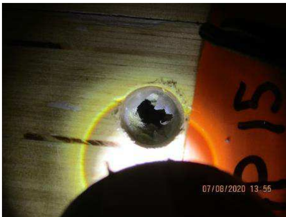
Kuva 44. Rakenneavaus AP15. Parketin alapinnalla on muovikalvo.
