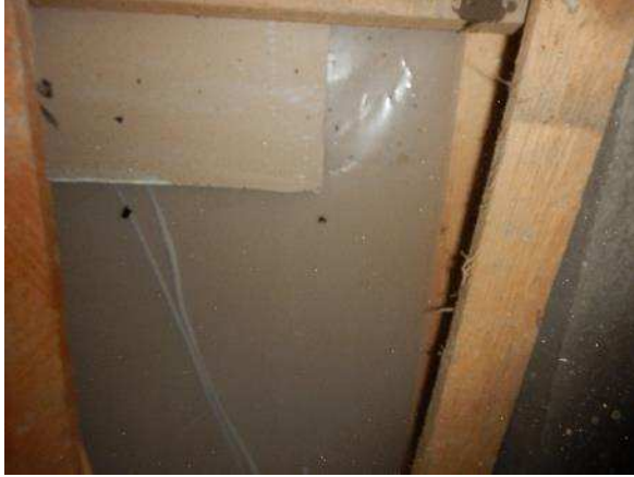
Kuva 364. Rakennuksen keskiosalla yläpohjaeristeen alapuolella havaittiin höyrynsulkumuovi.
