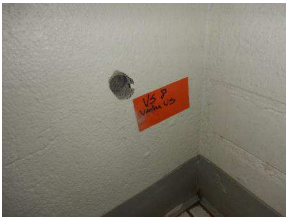
Kuva 279. Rakenneavaus tehtiin porrassseinälle.
