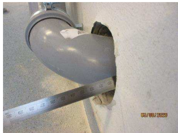
Kuva 274. Kuva viemärin läpiviennistä
