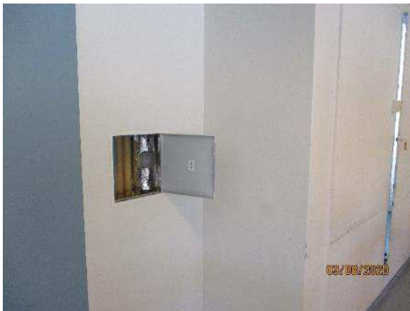
Kuva 277. Luokan käytävänpuoleisessa väliseinässä oleva putkien tarkistusluukku
