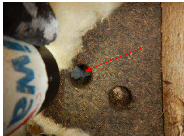
Kuva 170. Tuulensuojalevyn takana oli tuuletusväli ja julkisivun aaltopelti.
