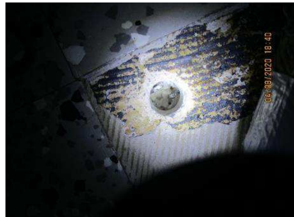
Kuva 20. Kuva avauksesta AP3. Pintalaatan ja kantavan betonilaatan välissä on eps-eriste.
