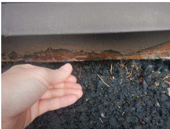
Kuva 397. Sisäpihan puolella havaittiin patolevyt sokkeliä vasten.
