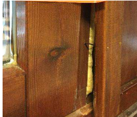
Kuva 147. Ikkunaliittymä oli tiivistetty uretaanivaahdolla.
