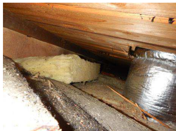
Kuva 363. Alkuperäisen vesikatteen aluslaudoituksessa ei havaittu viitteitä puutteellisen tuuletuksen aiheuttamista puurakenteiden vaurioista.
