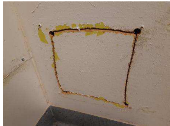
Kuva 161. Luokan ulkoseinä on levyrakenteinen.
