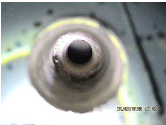
Kuva 37. Rakenneavaus AP10, Rakenneavaus rajautuu alla olevaan putkikanaaliin.
