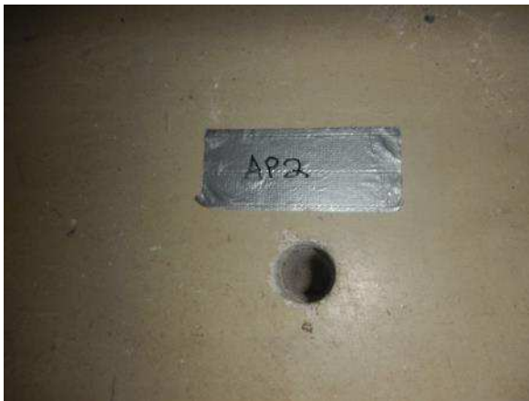
Kuva 17. Rakenneavaus Kiinteistöhoitajan tiloissa..
