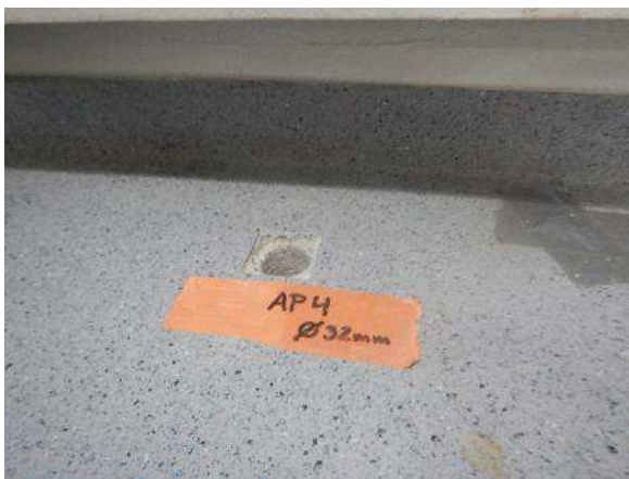
Kuva 21. Rakenneavaus suoritettiin ulkoseinän viereen 31 Kotitalousluokassa.
