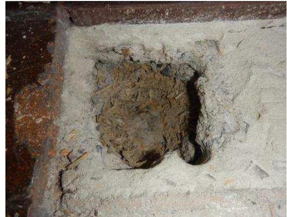
Kuva 236. Puukuitusementtilevyn alla on bitumisively.
