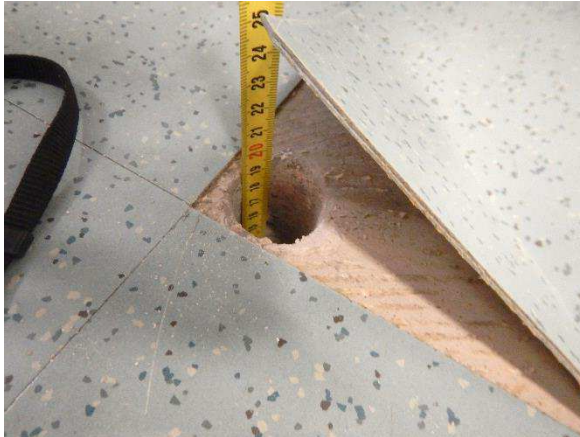
Kuva 39. Rakenneavaus AP 11 tehtiin pajarakennuksen entiseen kotitalousluokkaan.
