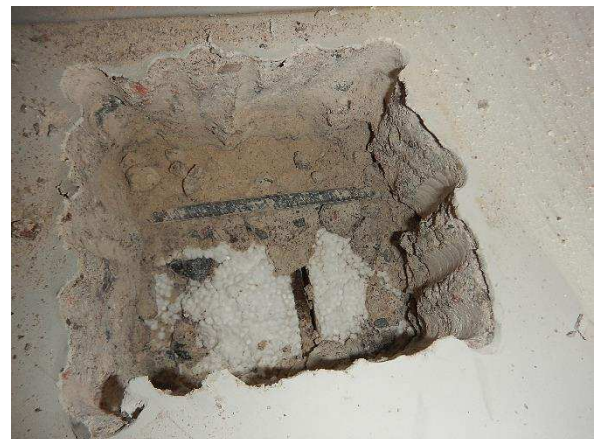
Kuva 28. Pintalaatan alla on EPS-eriste, jonka alla on hiekkatäyttöä.
