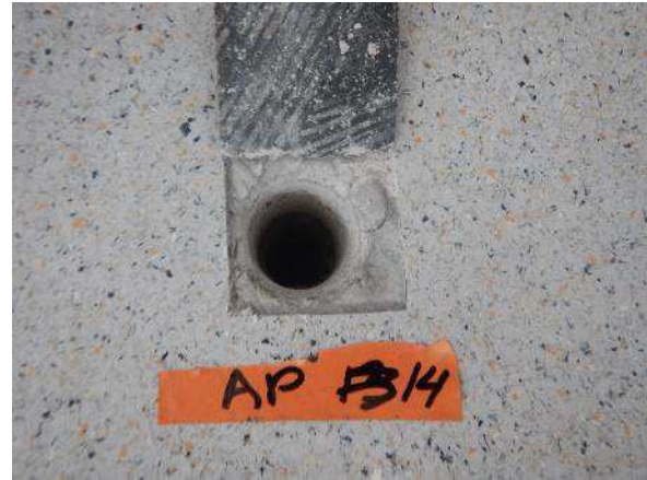
Kuva 32. Rakenneavaus AP14 tehtiin Kielet varastoon.
