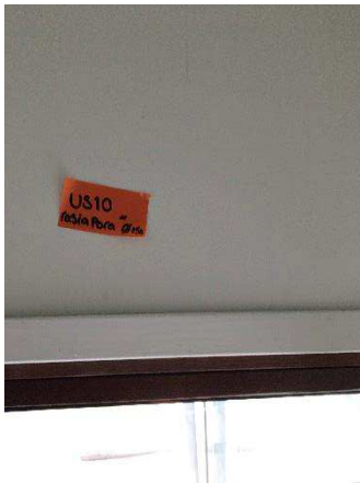
Kuva 124. Rakenneavaus US10 tehtiin ikkunan yläpuolelle.
