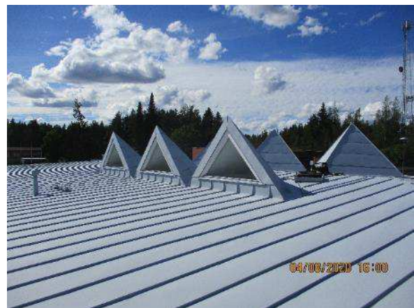
Kuva 327. Yleiskuva laajennusosan vesikatolta.
