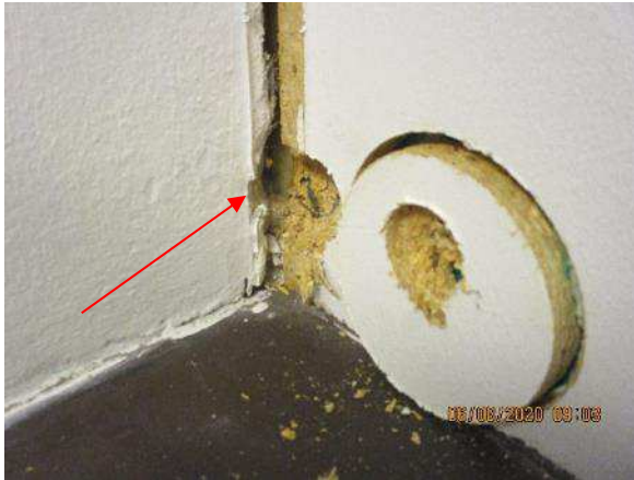
Kuva 171. Pilarin ja ulkoseinän välinen liittymä oli tiivistetty mineraalivillalla (kuva US 26 28 Kielet).
