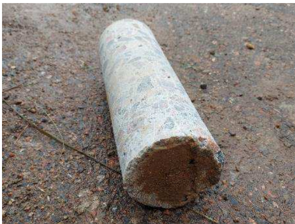
Kuva 103. Sokkeli on avauskohdassa massiivibetonirakenteinen.
