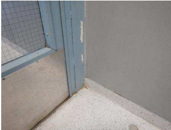
Kuva 229. Rakenneavaus VP 1 1030 käytävällä WC-tilojen ulkopuolella.
