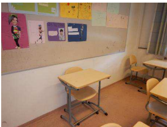
Kuva 165. Rakenneavaus tehtiin luokan päätyseinään.
