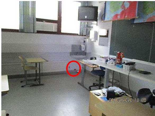
Kuva 155. US20:Rakenneavaus tehtiin ulkoseinään vesipisteen alle.
