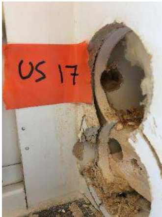
Kuva 148. Rakenneavaus tehtiin Apulaisrehtorin ja Rehtorin huoneiden väliseen väliseinän ikkunaliittymään.
