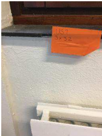
Kuva 105. Rakenneavaus tehtiin ikkunan alapuolelle.
