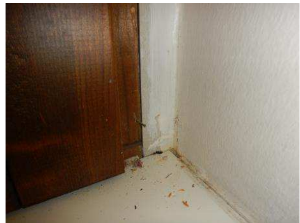
Kuva 137. Ikkunalistan takana on kipsilevy.
