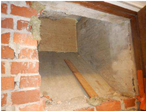
Kuva 227. Ruokalan ja teknisten tilojen välipohjarakenteessa on vanhoja huoltoluukkuja.
