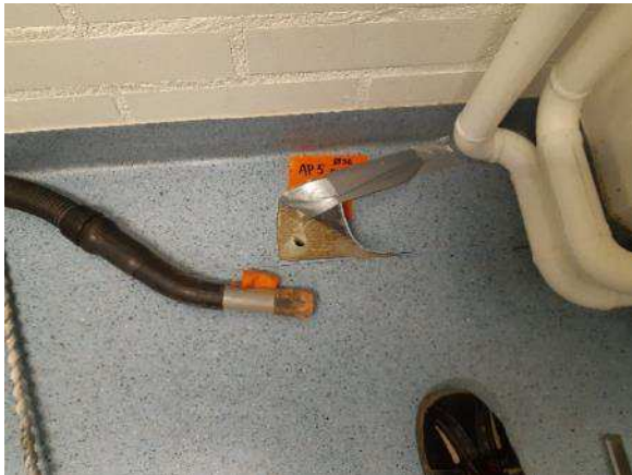
Kuva 23. Rakenneavaus AP5 tehtiin huoneen ulkonurkkaan.
