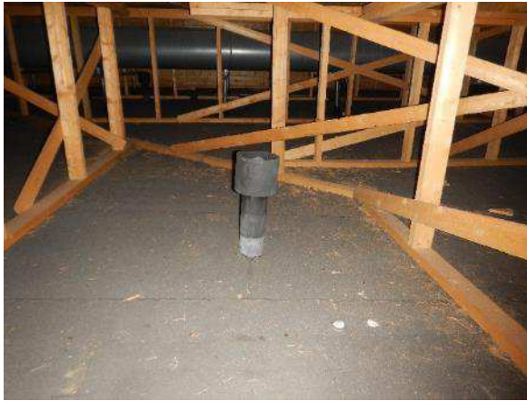
Kuva 358. Yläpohjatilassa oli alkuperäisen yläpohjatililan tuuletusputki.
