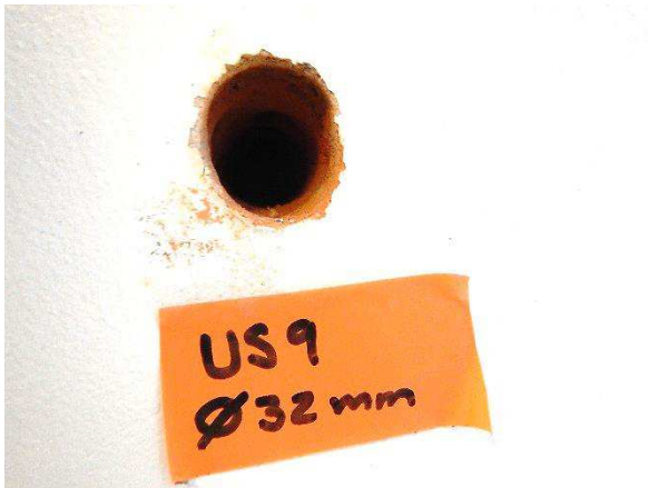
Kuva 122. Rakenneavaus tehtiin poraamalla ikkunan alle.
