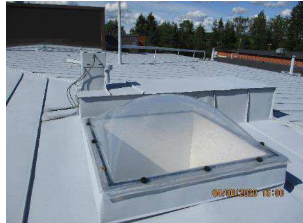
Kuva 329. Laajennusosassa on kattoikkunoita.
