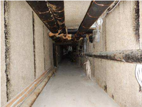
Kuva 294. Kuva Putkikanaali 2 Pajan puolelta.
