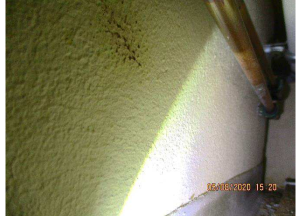
Kuva 256. Kotelointi on rakennettu olemassa olevien pintamateriaalien päälle. Koteloinnissa ei havaittu vuotojälkiä eikä kuitupitoisia putkieristeitä.
