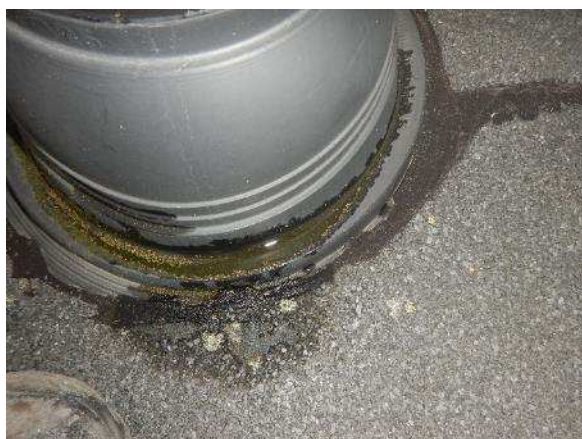
Kuva 350. Yleiskuva pajarakennuksen vesikatteen läpiviennistä.
