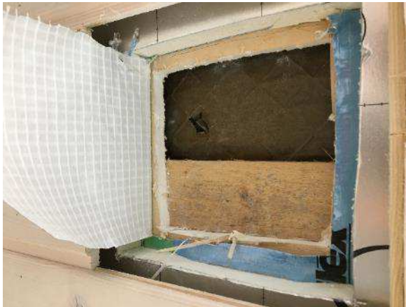
Kuva 377. Rakenneavaus YP4 tehtiin käytävään 1030.
