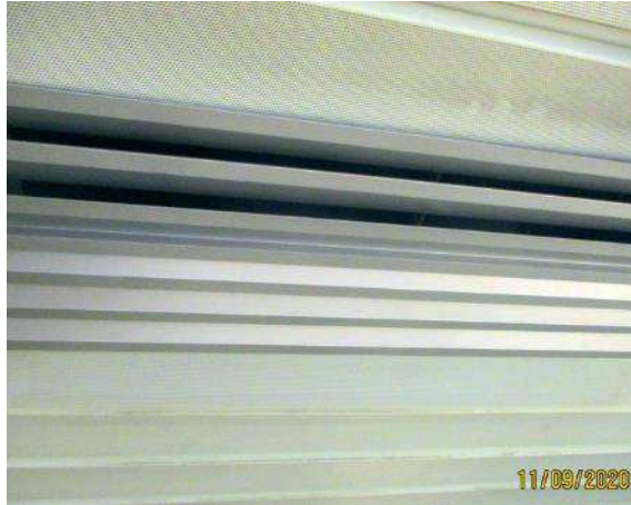
Kuva 499. Laajennusosa, käytävän alkuperäinen ALD-tuloilmasäleikkö
