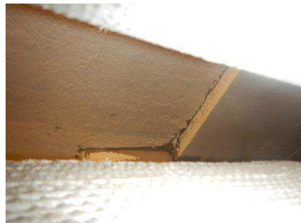
Kuva 226. Teknisissä tiloissa katoissa on osittain maalatut puukuitusementtilevyt.
