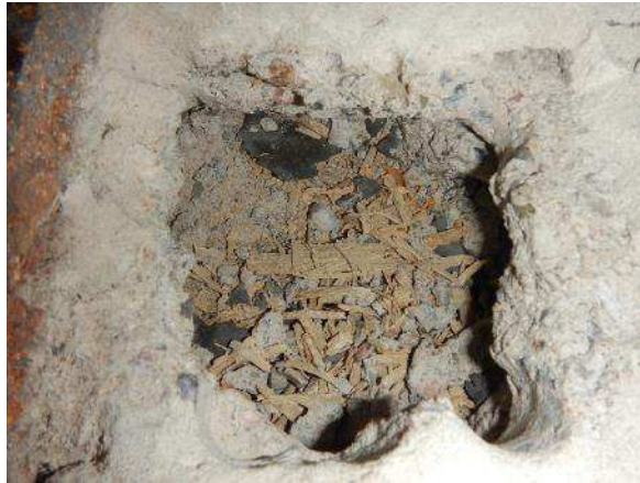
Kuva 235. Pintabetonilaatan alla oli tervapaperi ja puukuitusementtilevy.
