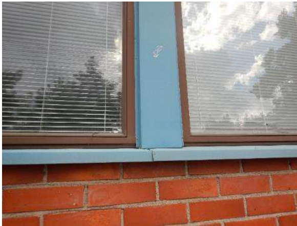
Kuva 150. Mineraalivillan takana on suoraan ikkunapellitys.
