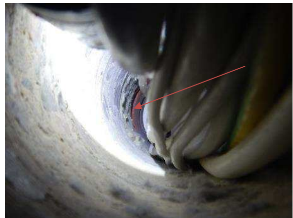
Kuva 280. Portaikon ja sisäänkäynnin väliseinän sisällä havaittiin mineraalivillaeriste.
