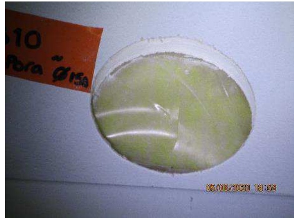
Kuva 125. Kipsilevyn takana on höyrynsulkumuovi ja mineraalivillaeriste.
