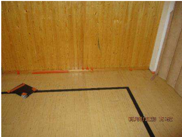
Kuva 223. Osa liikuntasalin lattiasta on välipohjarakennetta.
