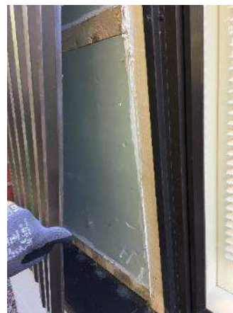
Kuva 108. Aaltopellin takana on polyuretaanilevy.
