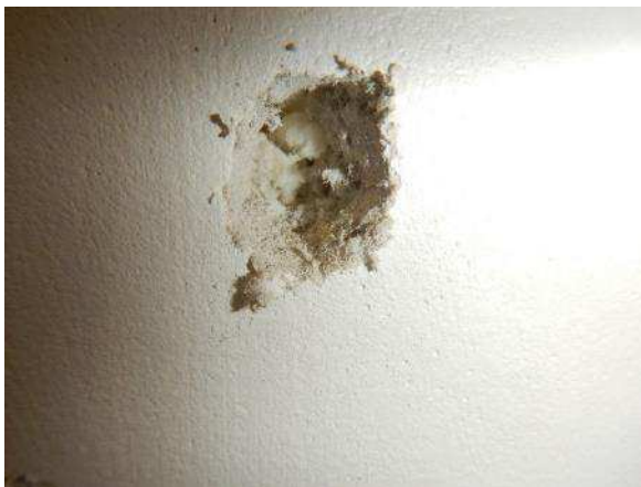
Kuva 109. Rakenteen sisäverhouslevynä on kipsilevy, jonka takana on havaittavissa uretaanieriste.
