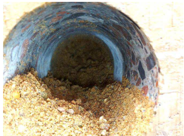
Kuva 104. Avauksen kautta havaittiin, että alapohjan täyttöaineena on käytetty hiekkaa.
