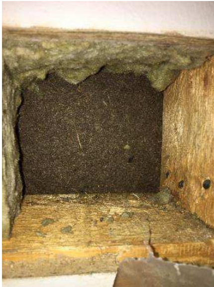
Kuva 119. Rakenneavaus tehtiin musiikkivarastoon ikkunan yläpuolelle.
