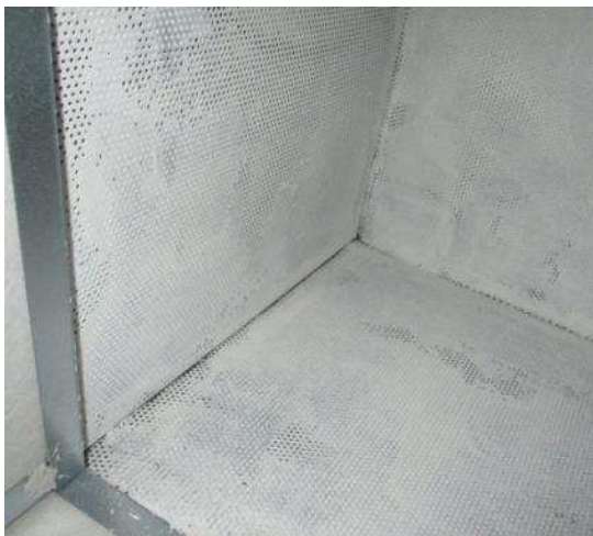
Kuva 455. Tuloilmakammion mineraalivillaa sisältävälle osuudelle on suoritettu pölynsidontakäsittely
