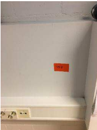
Kuva 271. Rakenneavaus tehtiin luokan ikkunaseinälinjalla kulkevaan putkikotelointiin
