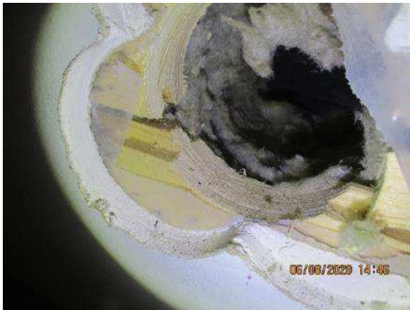
Kuva 174. Rakenneavaus US 28. Höyrynsulku- muovin ulkopinnalla on ponttilaudoitus.
