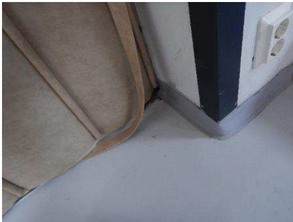
Kuva 238. Rakenneavaus VP 5 tehtiin ruokalaan lii- kuntasalin pilarin juureen.
