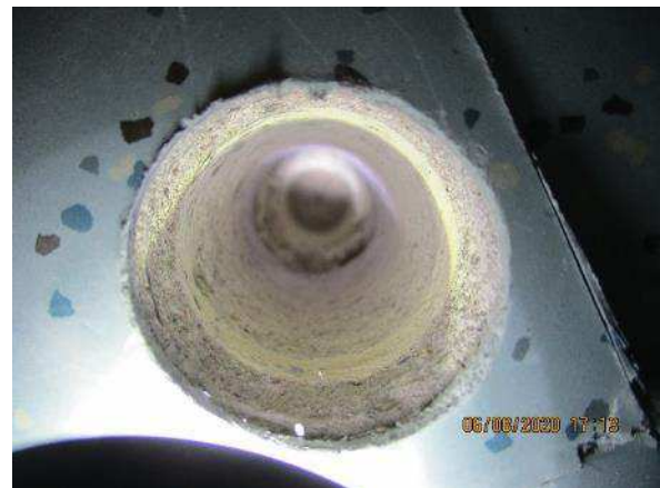
Kuva 38. Rakenneavaus AP10. Pintakerroksien alapuolella on havaittavissa tasainen kerros todennäköisesti vanhaa lattiapintaa. Massa ei sisällä asbestia.
