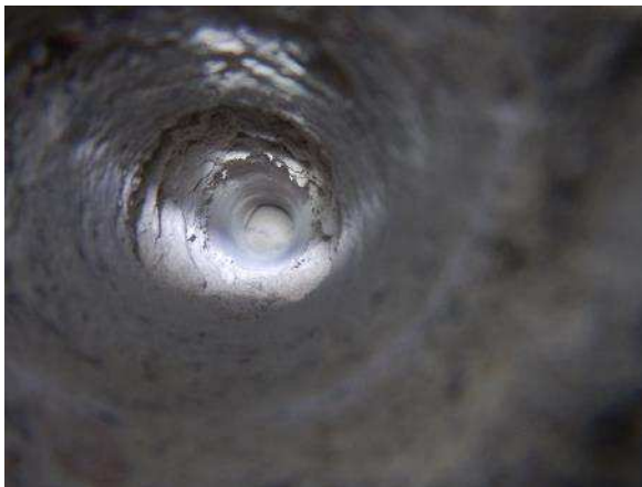
Kuva 33. Rakenneavaus AP14 kohdassa rakenne vastaa avauskohdan AP7 rakennetta. Hiekka on avauskohdassa pölyävää.
