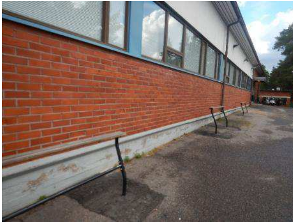
Kuva 189. Rakenneavaus tehtiin laajennusosan sokkelirakenteeseen.
