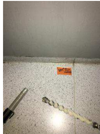
Kuva 230. Rakenneavaus tehtiin poraamalla.
