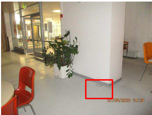
Kuva 27. Rakenneavaus AP 6 suoritettiin pilarin vierteen ruokalan sisääntulon lähelle.
