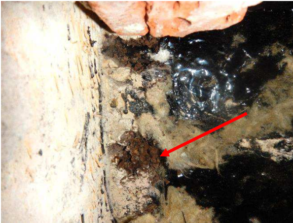
Kuva 117. RakenneavausUS6: Pilarin takana havaittiin korkkieristettä.
