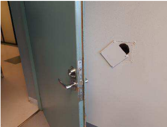
Kuva 267. Väliseinän rakenne tarkistettiin myös sei- nässä olevasta tarkastusluukusta.
