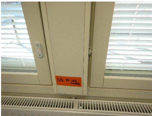
Kuva 139. Rakenneavaus tehtiin ikkunoiden väliin.
