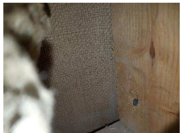
Kuva 264. Väliseinän sisällä oli vanha paljeovi.
