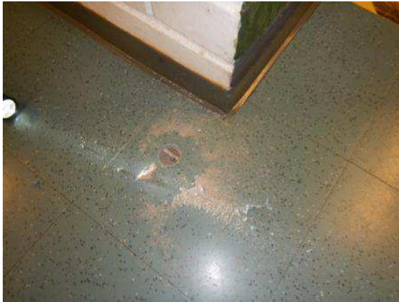
Kuva 41. Rakenneavaus tehtiin T14 käytävän nurkkaan.
