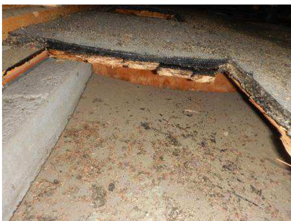
Kuva 362. Yleiskuva alkuperäisen vesikatteen rakenteesta. Mineraalivillaeristeen pinnalla on kovalevy.
