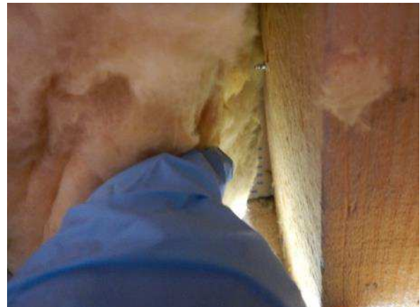
Kuva 143. Mineraalivillan takana on tuulensuojalevynä tuulensuojakipsilevy.
