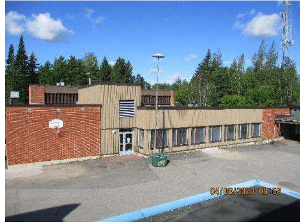
Kuva 81. Yleiskuva ruokalan laajennuksesta.
