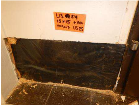
Kuva 167. Rakenneavaukset tehtiin ikkunan ja pilarin välissä olevaan levyrakenteeseen.
