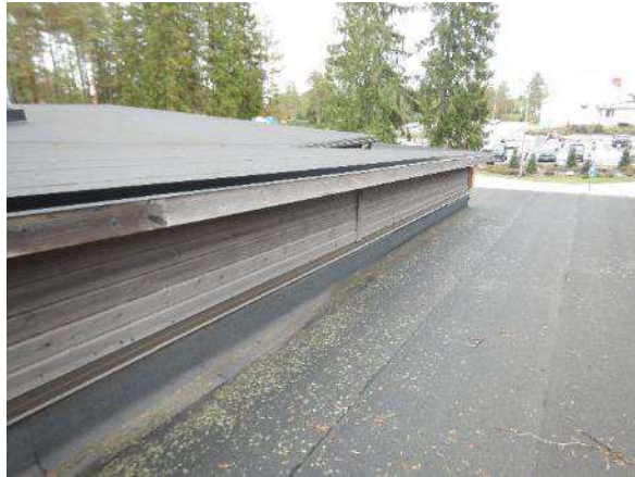
Kuva 340. Pajarakennuksen alkuperäisen vesikatteen päälle on rakennettu korotusosa, jonka sisäpuolella sijaitsee ilmanvaihtokanavistoja ja -puhaltimia.
