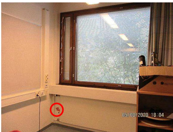
Kuva 176. Rakenneavaus US30 tehtiin kuvaan merkittyyn kohtaan.
