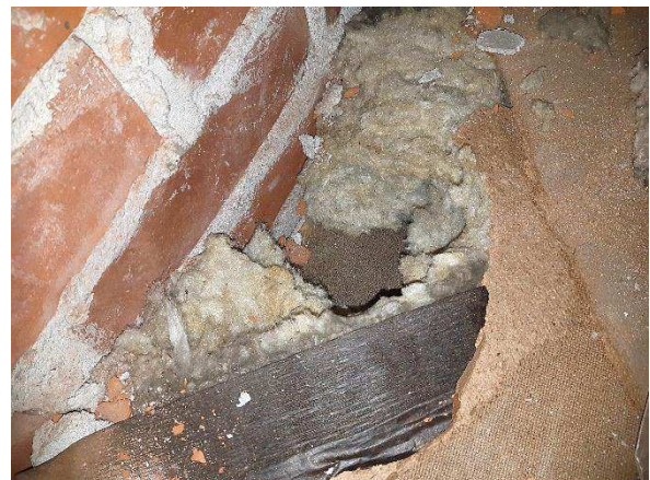
Kuva 368. Kuva avauksesta YP 1.
