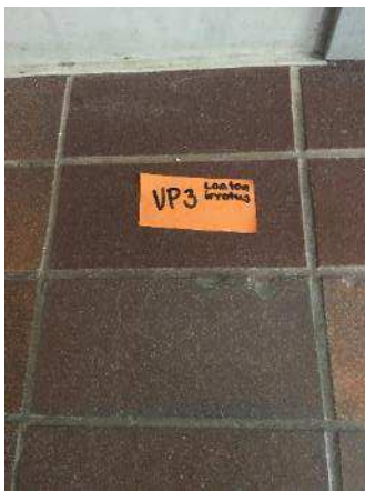
Kuva 233. Rakenneavaus tehtiin Aulaan sisäänkäynnin viereen.
