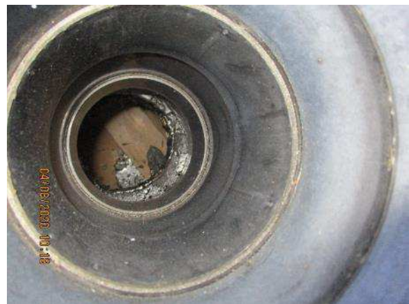
Kuva 325. Toisen kerroksen yläpohjatilan kuntoa arvioitiin tuuletusputkien kautta aistinvaraisesti.
