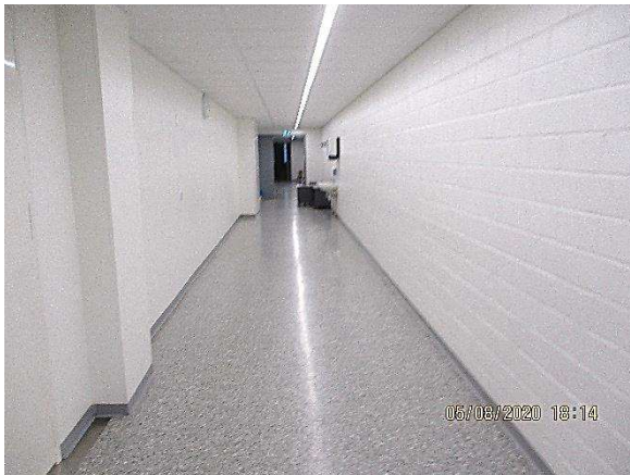
Kuva 68. Yleiskuva alkuperäisen rakennusosan kellarin käytävältä, jonka seinä on maanvastainen.
