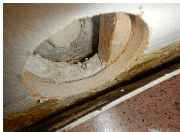
Kuva 166. Lastulevyn takana on EPS-eriste.
