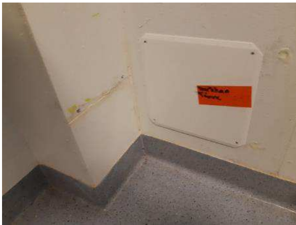
Kuva 160. Rakenneavaus US 22 tehtiin ulkoseinään vanhaan rakenneavaukseen.
