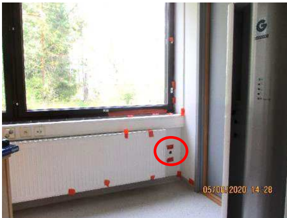
Kuva 110. Rakenneavaus US5 tehtiin kuraattorin työhuoneeseen kuvaan merkitylle kohdalle.
