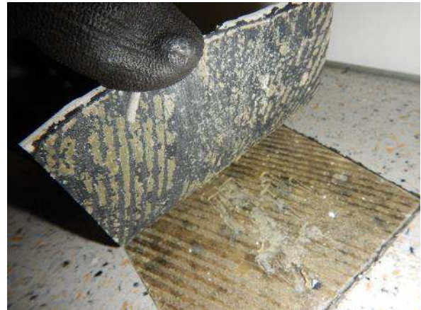
Kuva 54. VM2: Varasto/kielet-tilaan tehtiin viiltokosteusmittauksen vertailumittaus alueelle, jolla ei havaittu poikkeavuuksia pintakosteuksissa tai maatäytön kosteuspitoisuudessa. Lattiamatossa tai sen kiinnitysliimassa ei havaittu poikkeavuuksia.
