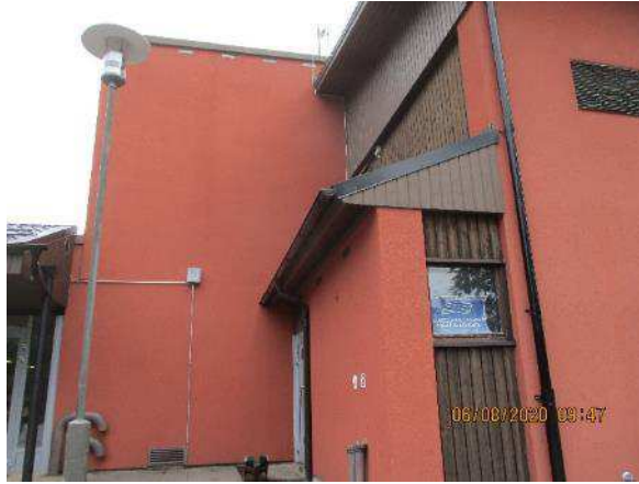
Kuva 80. Liikuntasalin ja keittiön julkisivut ovat hyväkuntoisia, havaintojen perusteella julkisivurappaukset on uusittu lähivuosien aikana.
