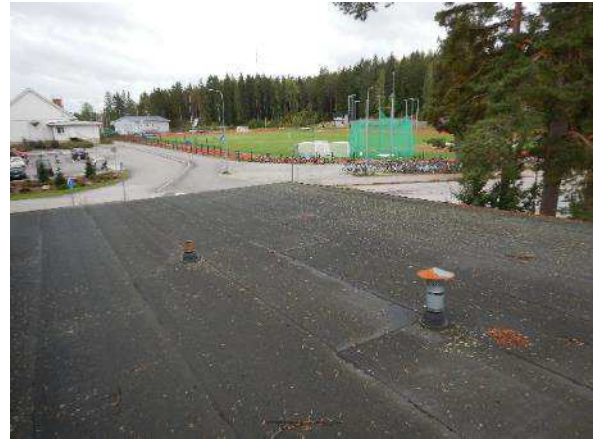
Kuva 341. Yleiskuva pajarakennuksen alkuperäisestä vesikatteesta sisäpihan puolella.
