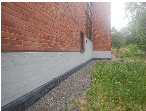
Kuva 393. Yleiskuva rakennuksen takaa. Rakennuksen takana havaittiin patolevyt ja sorastettu kaista sokkelin vierustalla.
