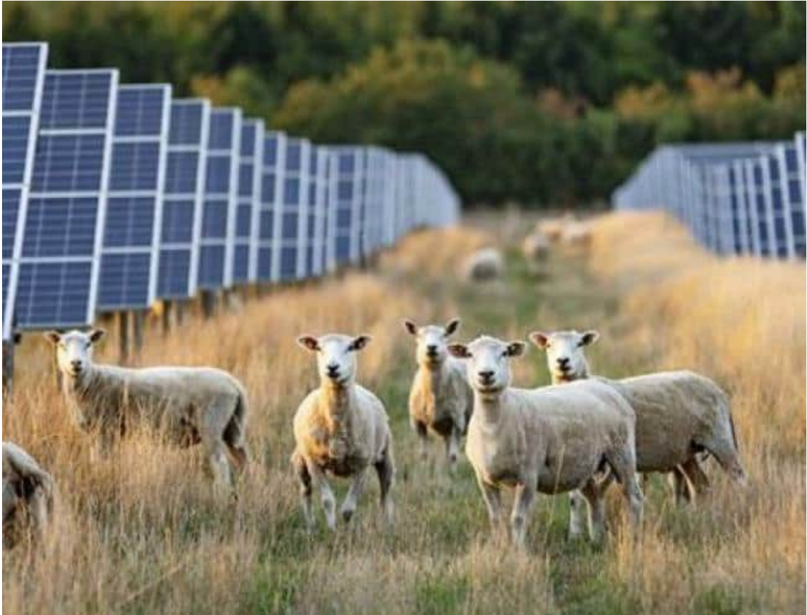
Kuva 7.3 Suurin osa aurinkovoimalan maanpinnasta säilyy kasvipeitteisenä. Ainoastaan huoltotiet, muuntajien vierustat ja sähköaseman ja energiavaraston alueet eivät ole nurmipeitteiset. Niihinkään ei rakenneta läpäisemätöntä pinnoitetta, kuten asfalttia. Kuva: Fortum.
