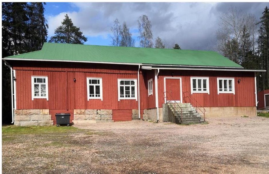
Kuva: Entinen työväentalo Vuorilinna on yksi Tarvasjoen vanhimmista rakennuksista
